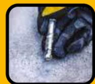
La utilización de un componente de expansión, bien en la base del orificio o a lo largo de la longitud del anclaje, pueden utilizarse anclajes de expansión **DEWALT** para soportar grandes cargas. Debido a que funcionan por fricción con el material base para proporcionar agarre, imparten esfuerzos de dilatación al soporte base. Para conseguir una fijación segura hay que tener siempre cuidado cuando se trabaja en las distancias del borde y tolerancias de separación.
